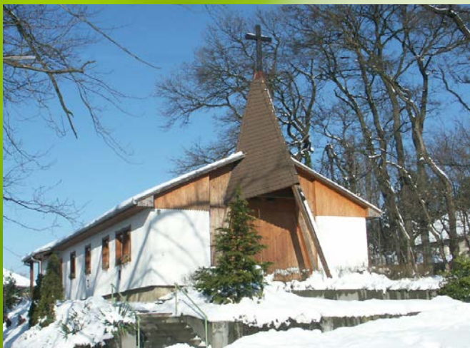
Die beschädigte Holzkirche Piliscsaba
