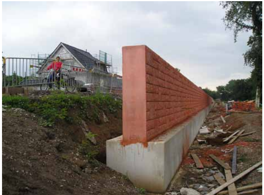
Hochwasserschutzmauern an der Mulde vor Eilenburg
