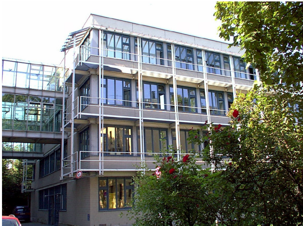
Abb. 40 - Anbau Meiserstr. (Foto: Andreas Siegel)
